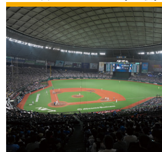
225ブロック-42段付近
